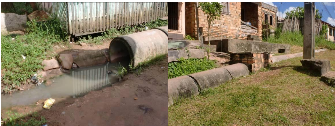
Figura 37: Serviço de esgotamento sanitário no aglomerado subnormal Café Liberal.
