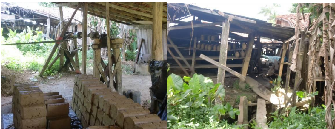
Figura 23: Blocos de argila no chão e peças semiacabadas na estante da olaria situada as margens do igarapé Livramento.
