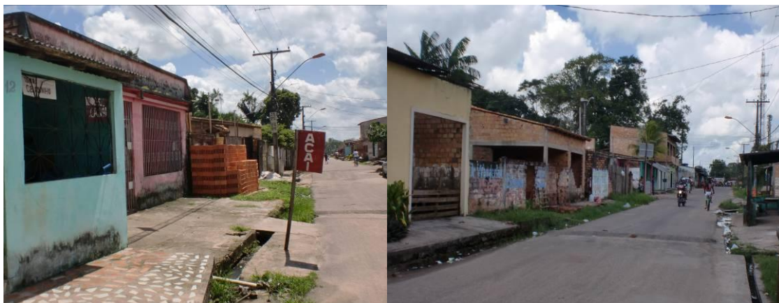
Figura 43: Na Rua Olaria I a pavimentação mascara as condições de vulnerabilidade.
