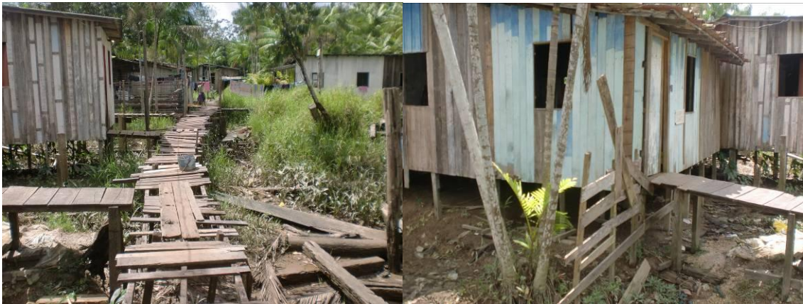
Figura 34: Domicílios e pontes de madeira na margem direita do rio Livramento.
