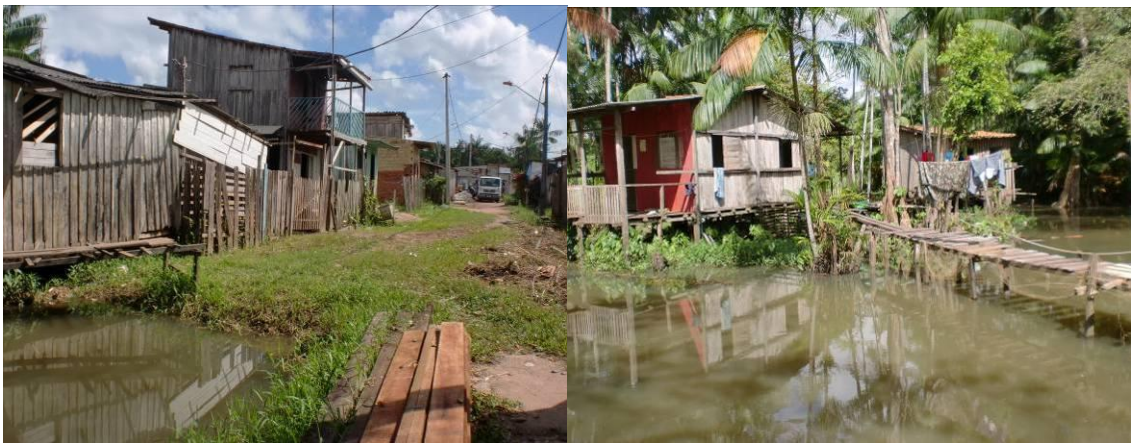
Figura 40: Condições irregulares de ocupação na Rua dos Cravos.
