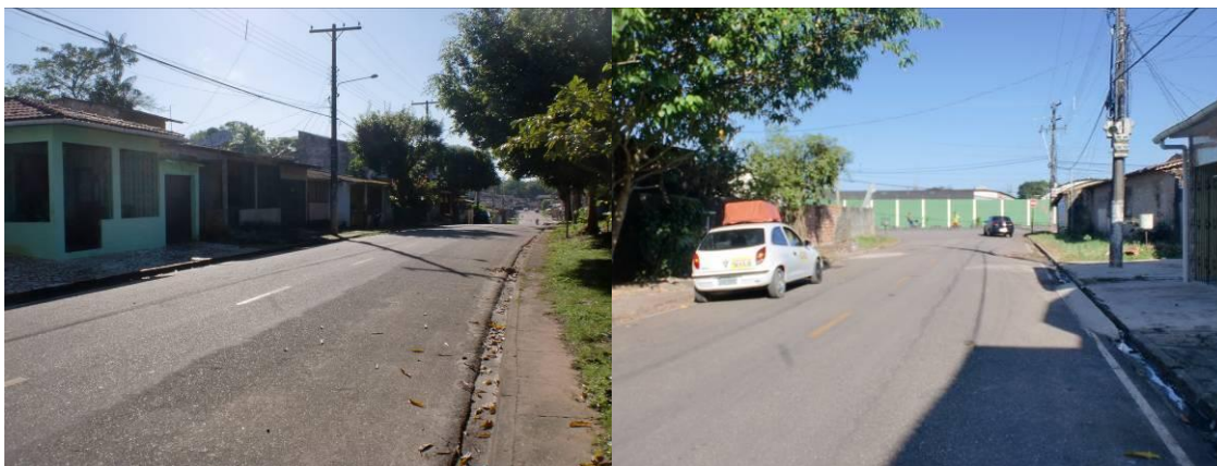
Figura 27: Padrão de ocupação e saneamento básico na Rua das Flores.
